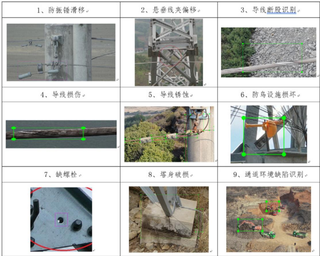
图 8-4 杆塔本体缺陷识别示意图
